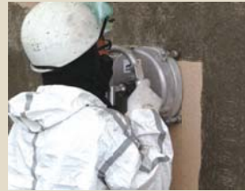
壁面のアスベスト剥離・吸引。煙突の内面など、密閉した 環境でも活躍。粉塵飛散を防ぎます。
